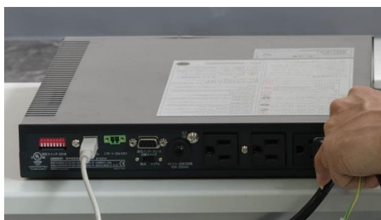
UPSを背面から撮影
