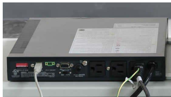
配線後の状態
