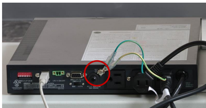
UPS を背面から撮影／配線後の状態
