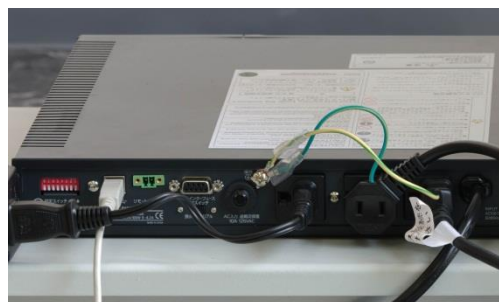
配線後の状態
