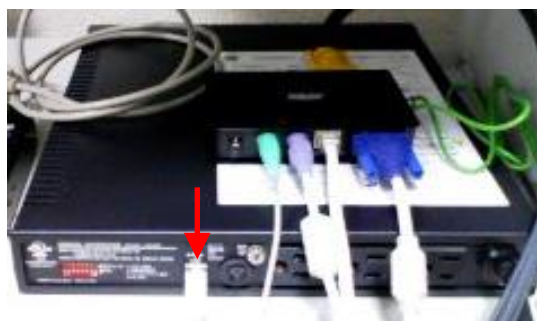
UPS を背面から撮影
