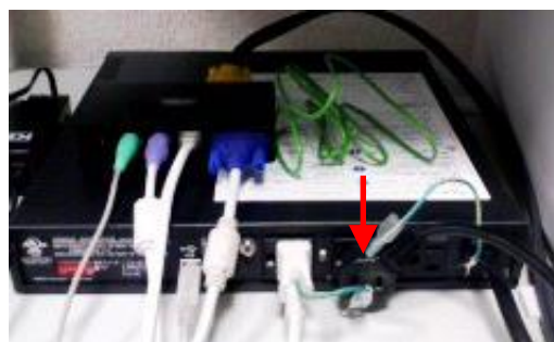
UPS を背面から撮影
