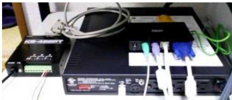
UPS を背面から撮影
