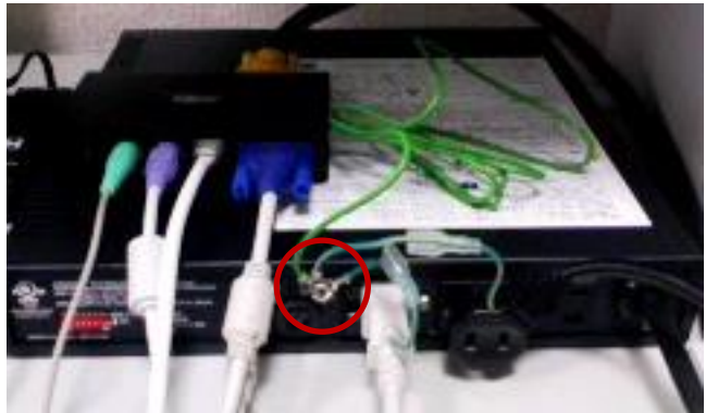
UPS を背面から撮影
