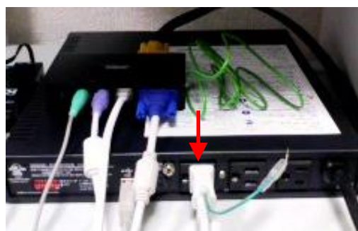
UPS を背面から撮影
