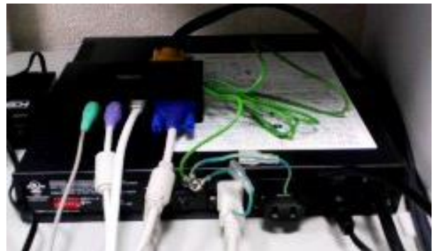
配線後の状態
