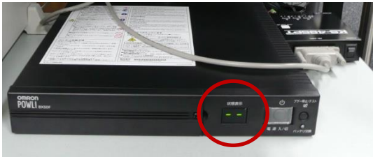
UPS を正面から撮影
