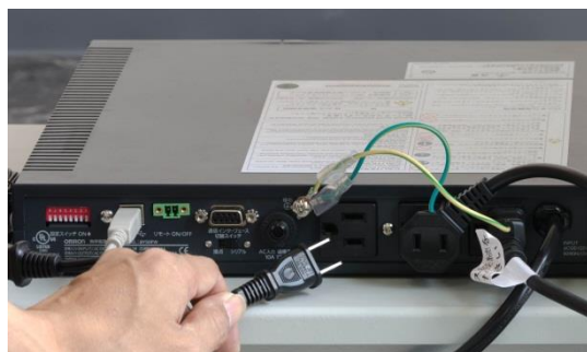
UPS を背面から撮影
