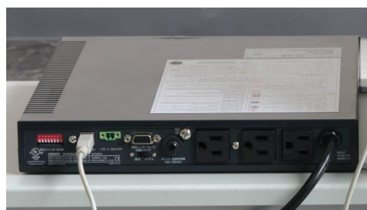
配線後の状態
