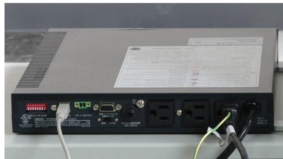
配線後の状態
