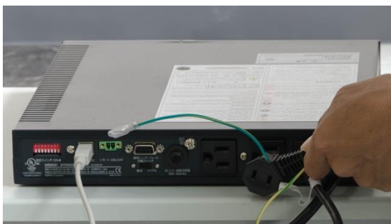
UPS を背面から撮影
