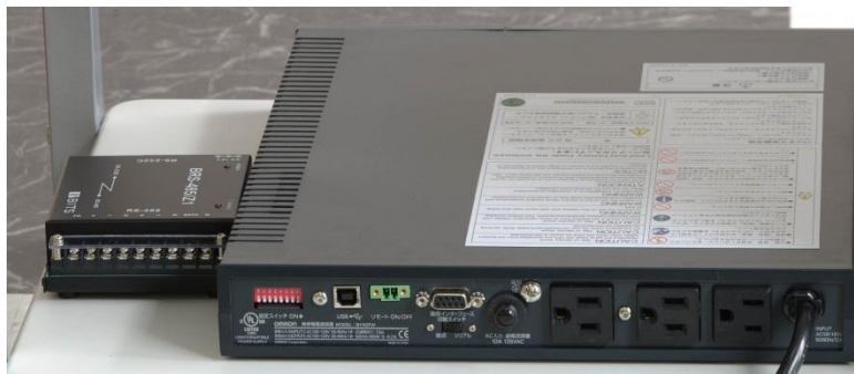
UPS を背面から撮影
