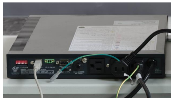
配線後の状態
